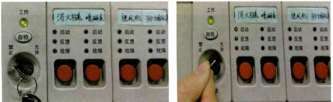
图6-76 将多线制控制盘由禁止状态转到允许状态
