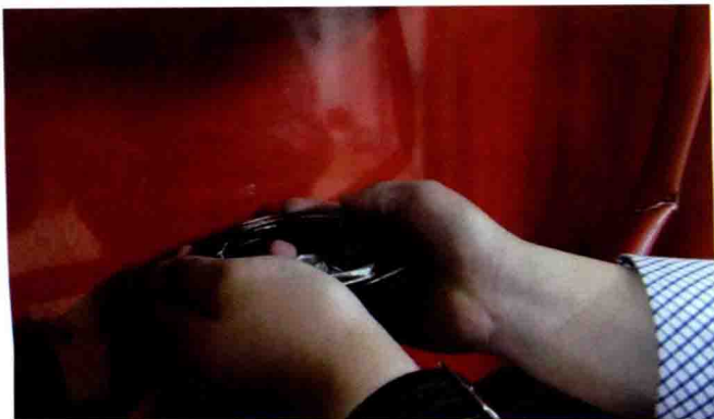
图8-42 关闭消火栓阀门
