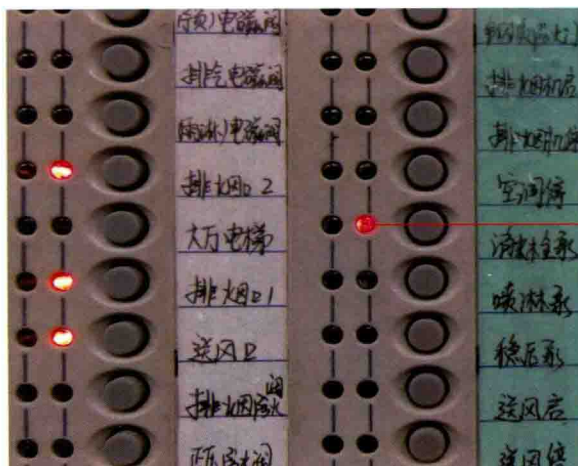
图6-80 消防手动控制盘上显示消火栓泵启动
