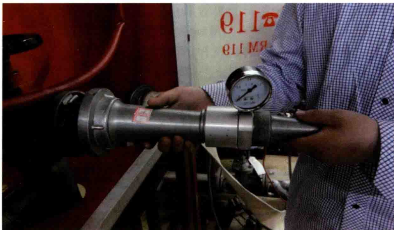
图8-34 连接消火栓和测压接头
