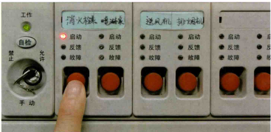
图6-77 多线制控制盘启动消防栓泵
