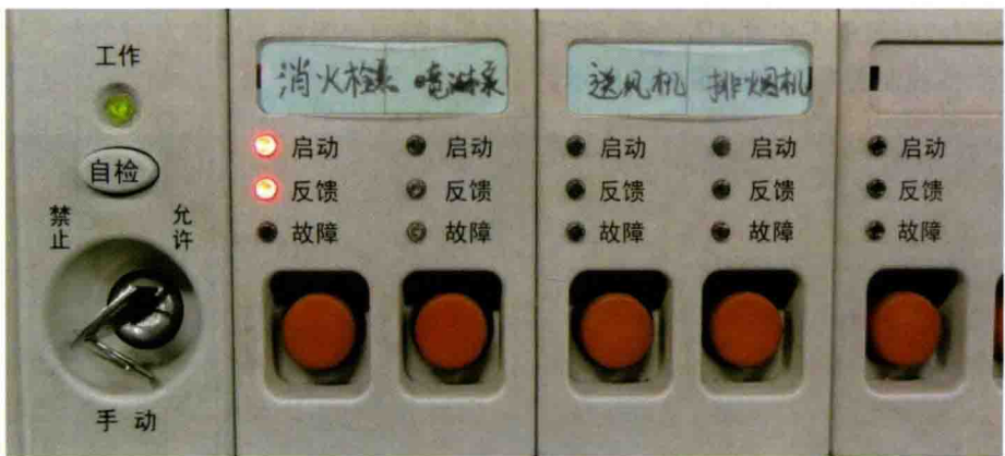
图6-78 消防栓泵启动反馈信号
