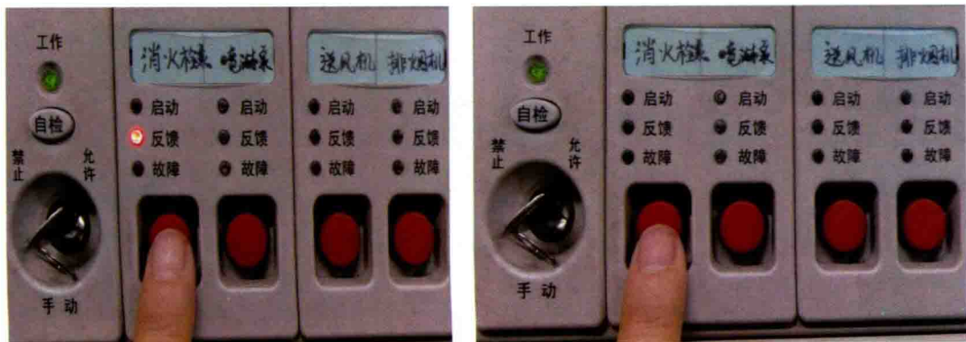
图6-81 停止消防水泵
