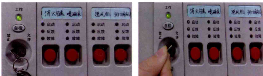
图 6-83 多线制控制盘由禁止状态转到允许状态
