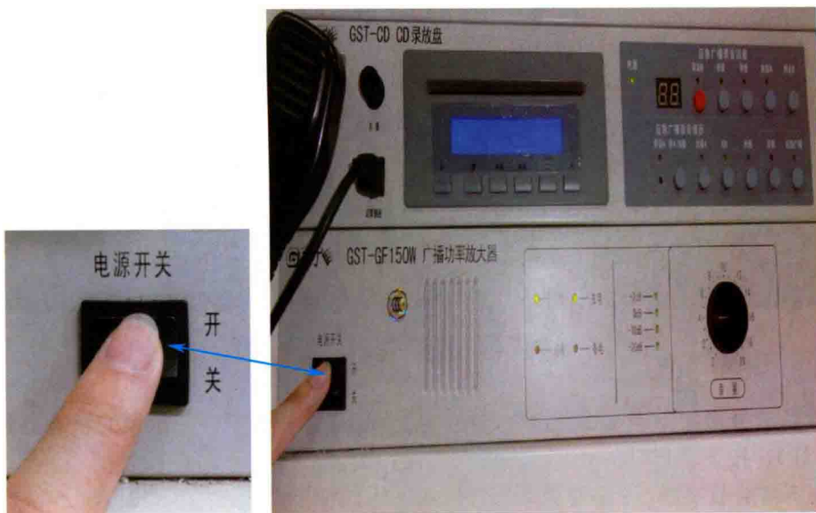
图9-48 打开广播功率放大器的电源开关
