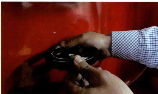
图8-40 打开消防栓阀门
